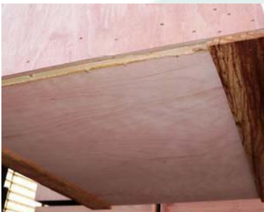
Kistbodem wordt afgesloten met 9mm multiplex.
