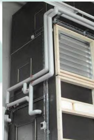
Verbinding van buizen naar de radiator binnen in het luchtverdeelsysteem.
